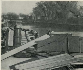
«Механизмы» старого Перервинского шлюза скреплялись лыком.
