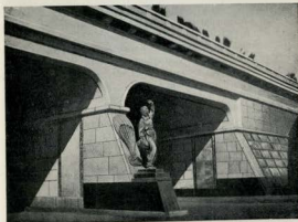
Волоколамский тоннель, проложенный под руслом канала.
