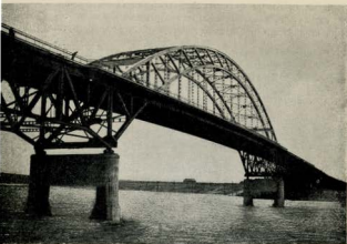
Мост Ленинградского шоссе, переброшенный через канал.
