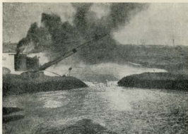
Экскаваторы расширяют путь повернутой Волге.
