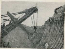
Ковш экскаватора взрывается в грунт.
