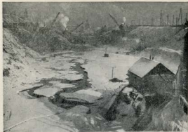
Земляные работы в котловане шлюза № 3.
