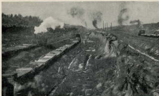
Земляные работы на Лесоводском буре.
