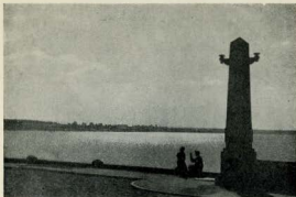
Клязьминское водозаборное сооружение.
